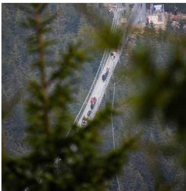
Okno na wiszący most
