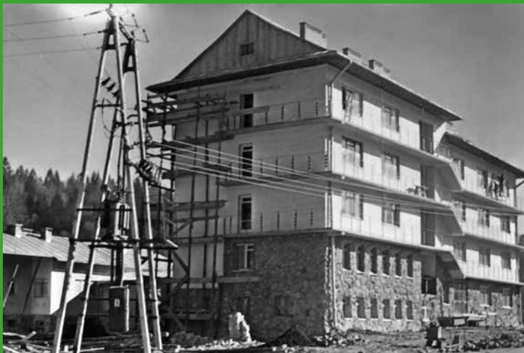
Muczne – hotel w czasie budowy. pocz lat 70. Arch. RDLP w Krośnie
